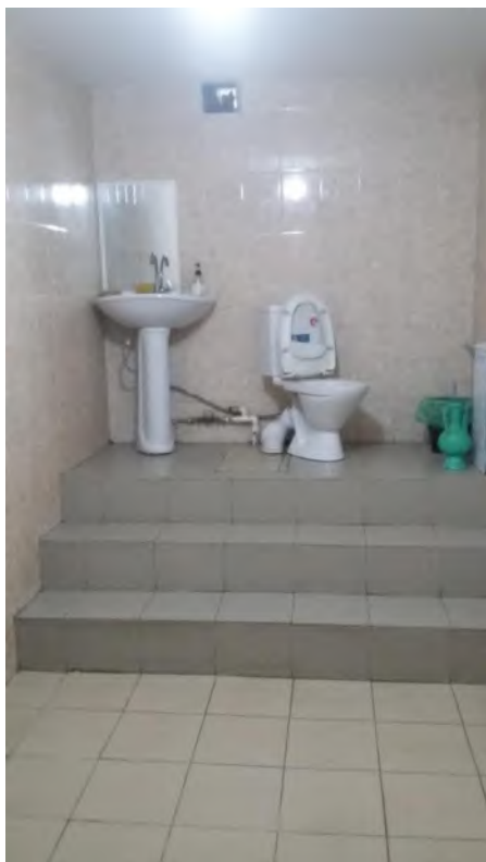
Фото №14. Служебный туалет в подвале.
