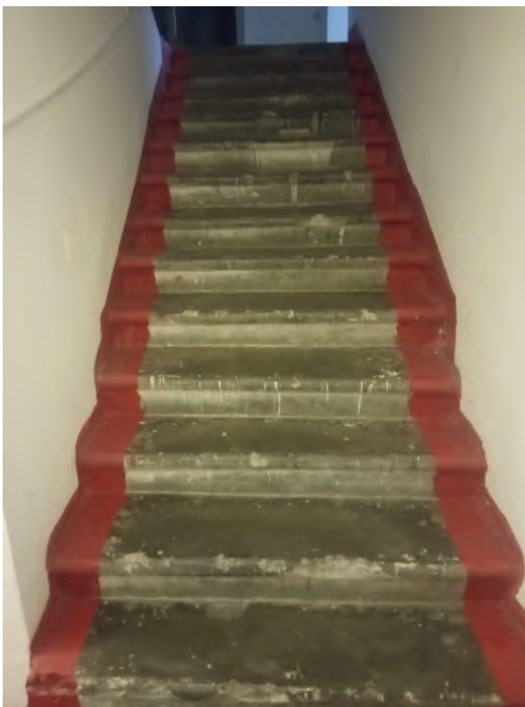
Фото №15. Лестница для спуска в подвальные помещения.
